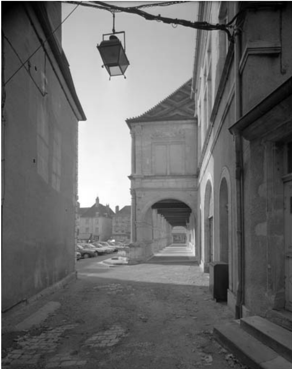
Façade latérale droite : vue du portique et du premier étage.
