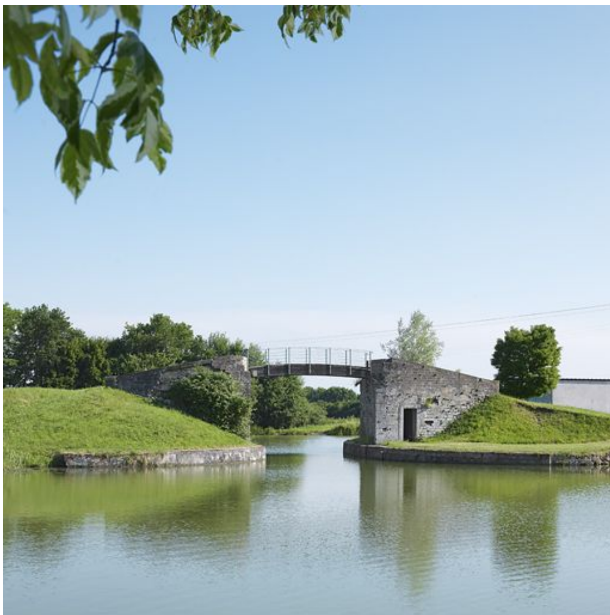
Vue de la passerelle haute, de face.
