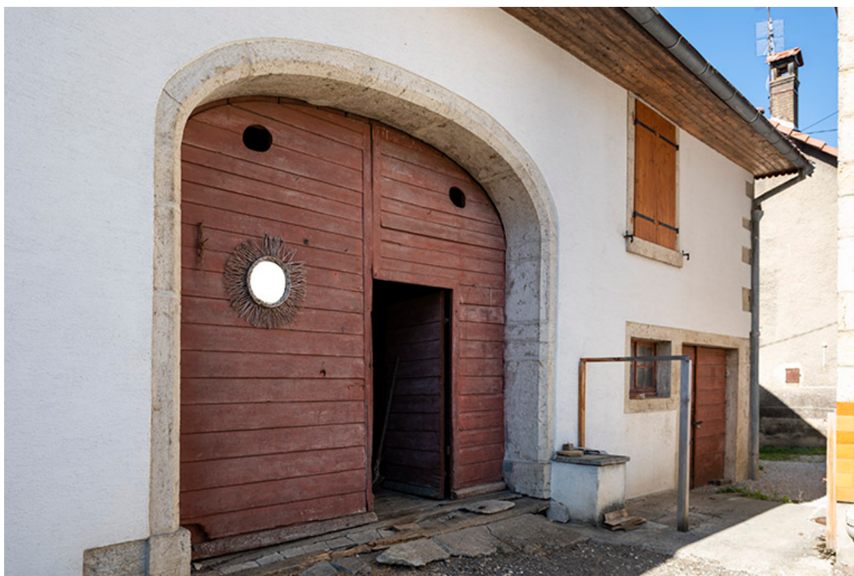
Grange : façade antérieure, de trois quarts gauche.
