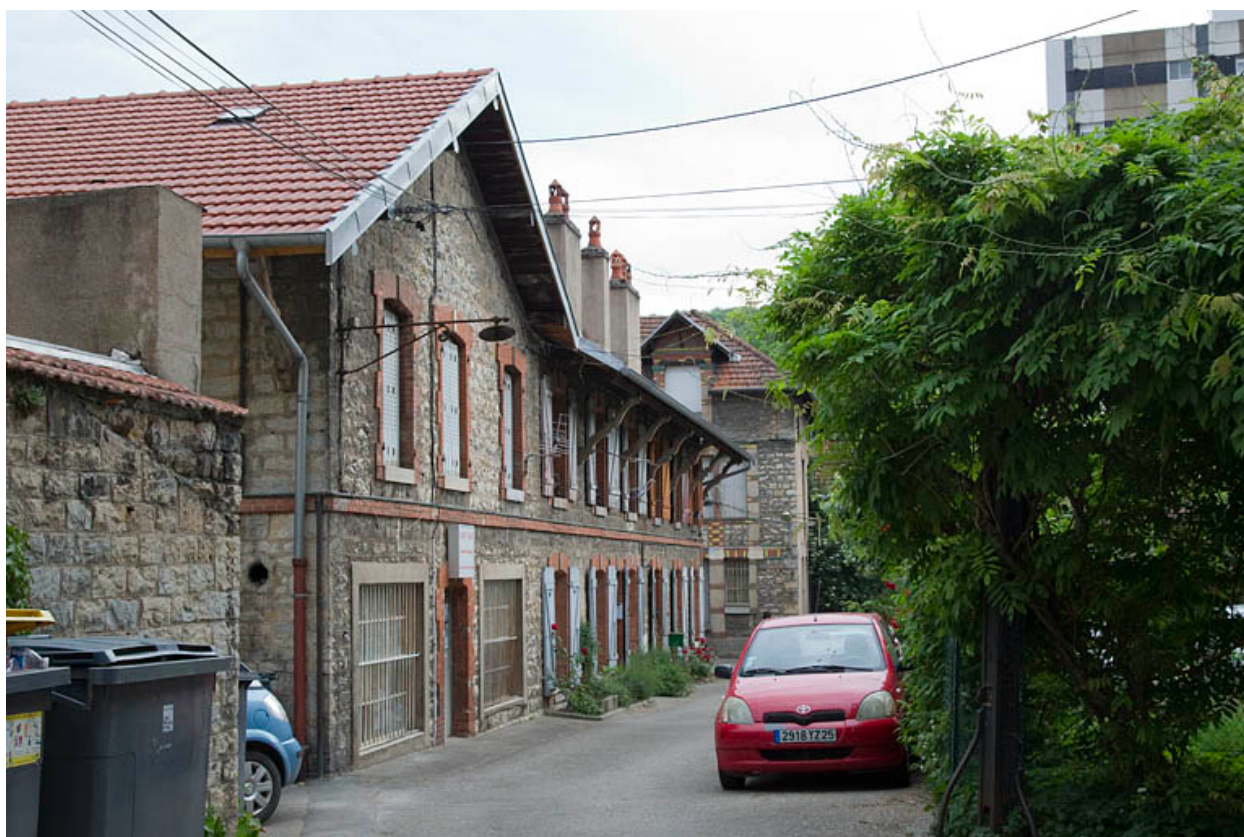
Bâtiment de la distillerie : vue de trois quarts gauche.
