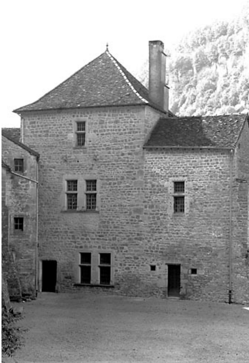
Façade sur cour de la tour de justice.
