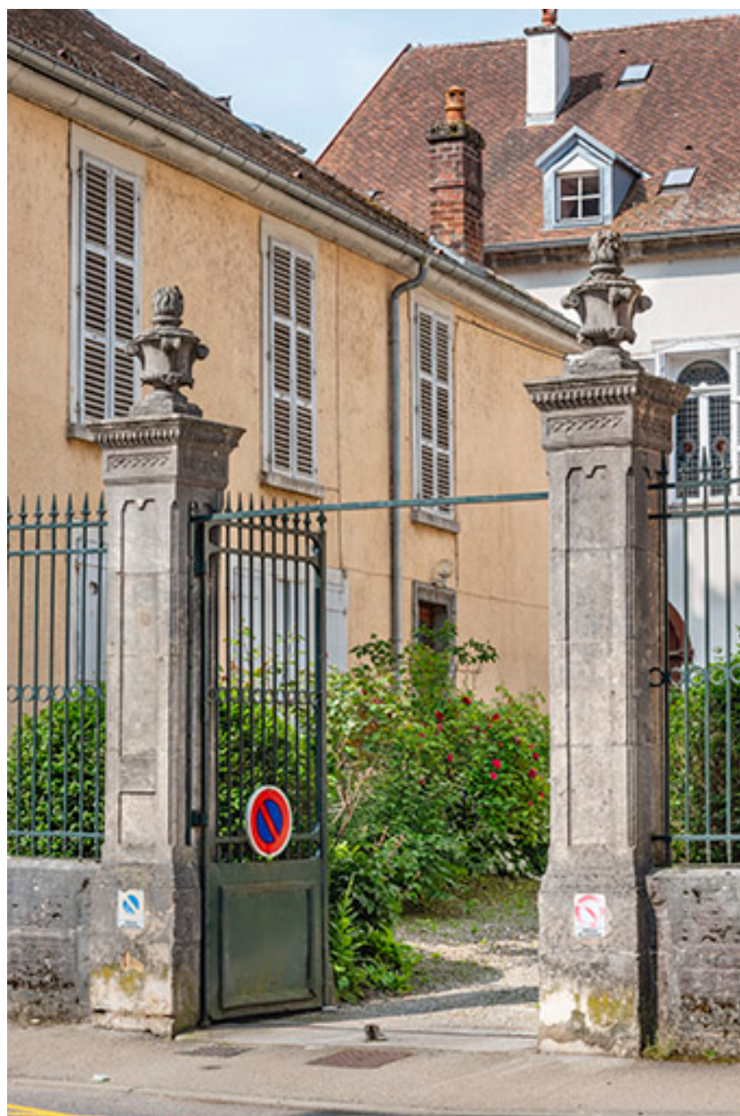
Porte d'entrée de la cour.
