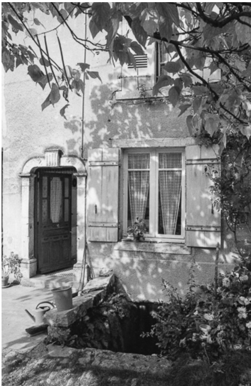
Détail : entrées de cave et d'habitation.
