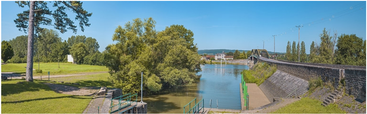
Le port et le pont de Fleurville vus depuis le canal de Pont de Vaux, rive gauche.
