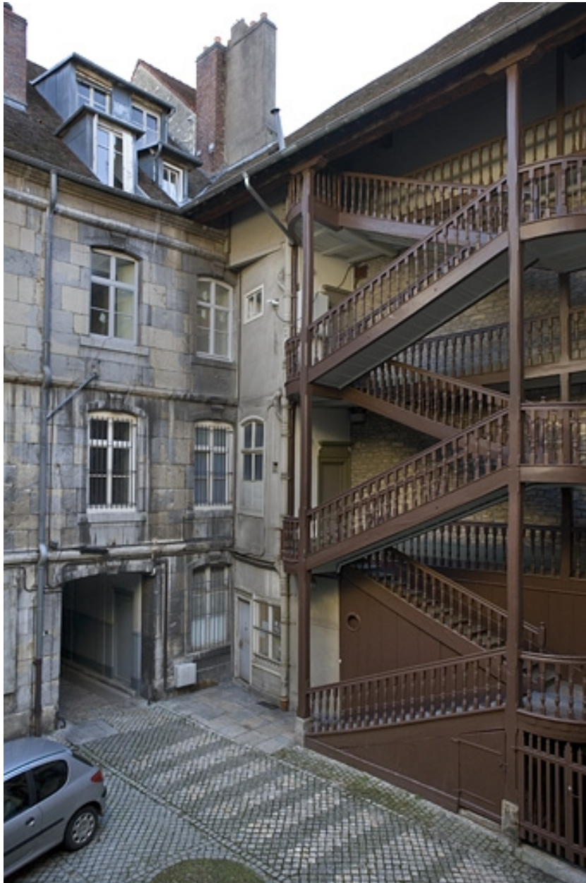
Vue de la façade postérieure du logis principal et de l'escalier gauche depuis le fond de la première cour.
