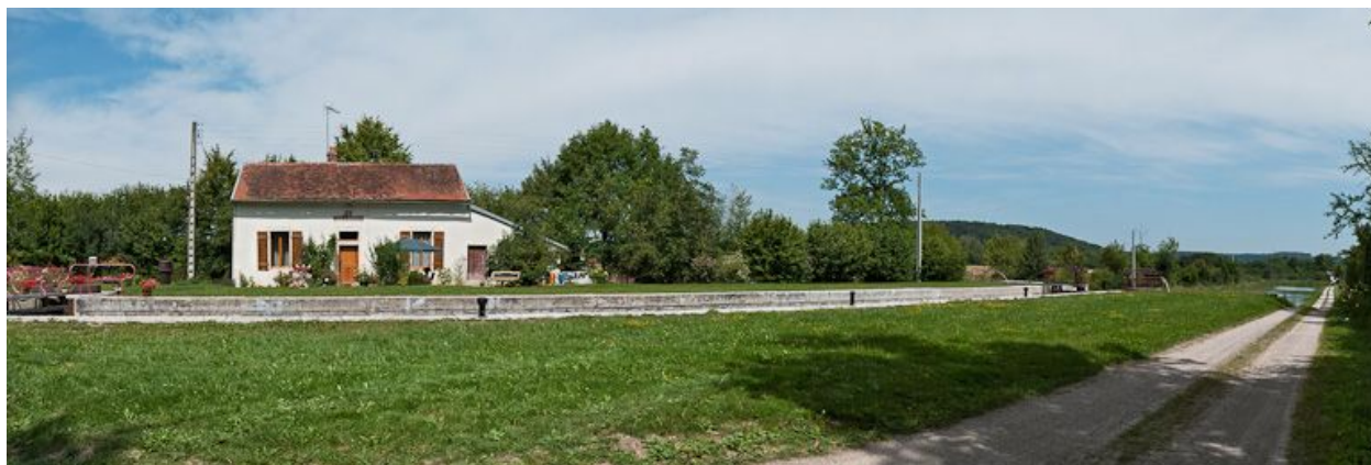
Vue d'ensemble du site d'écluse.
