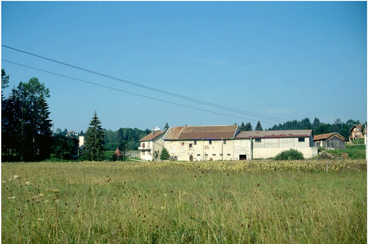
Ateliers de fabrication vus de l'est.
