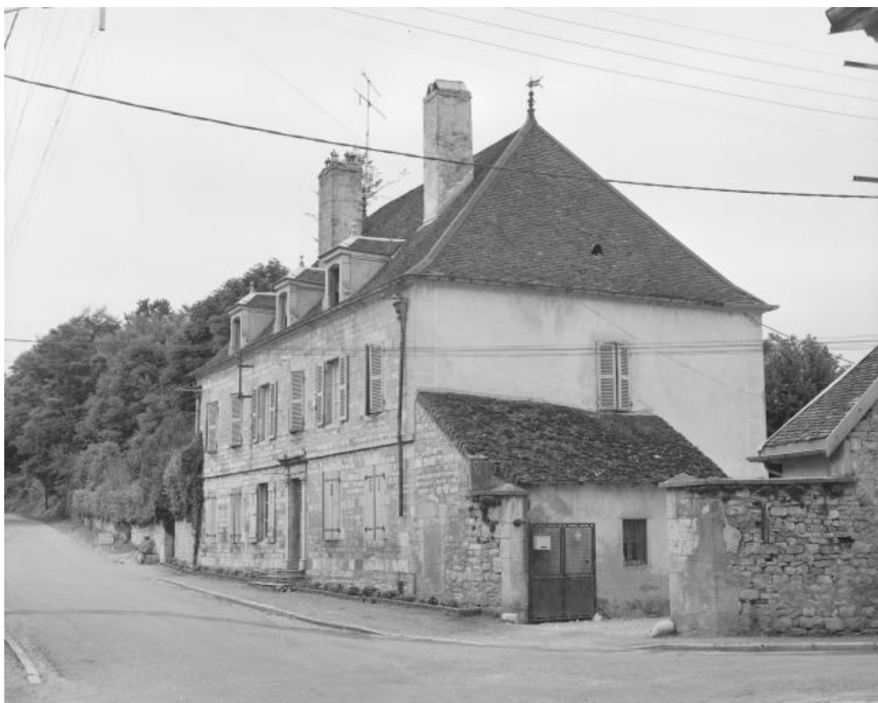
Façades antérieure et latérale droite.
