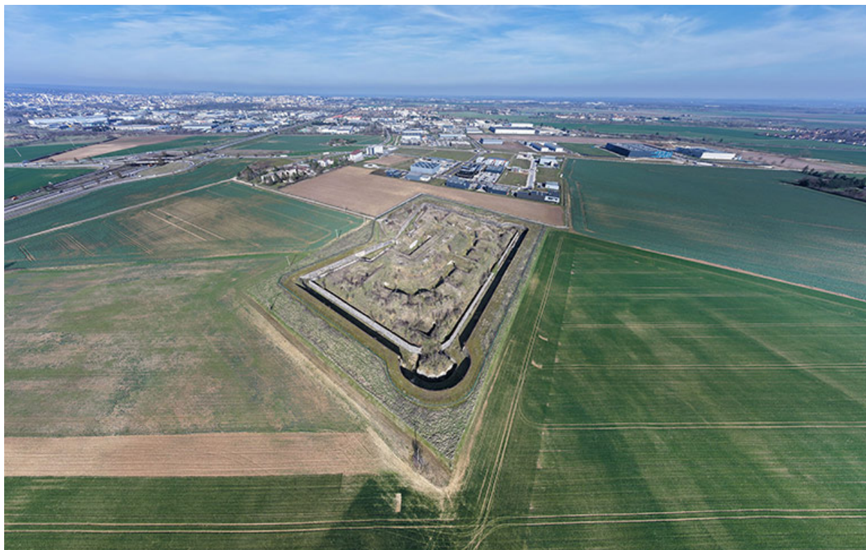
Vue sud-est. (vue aérienne).
