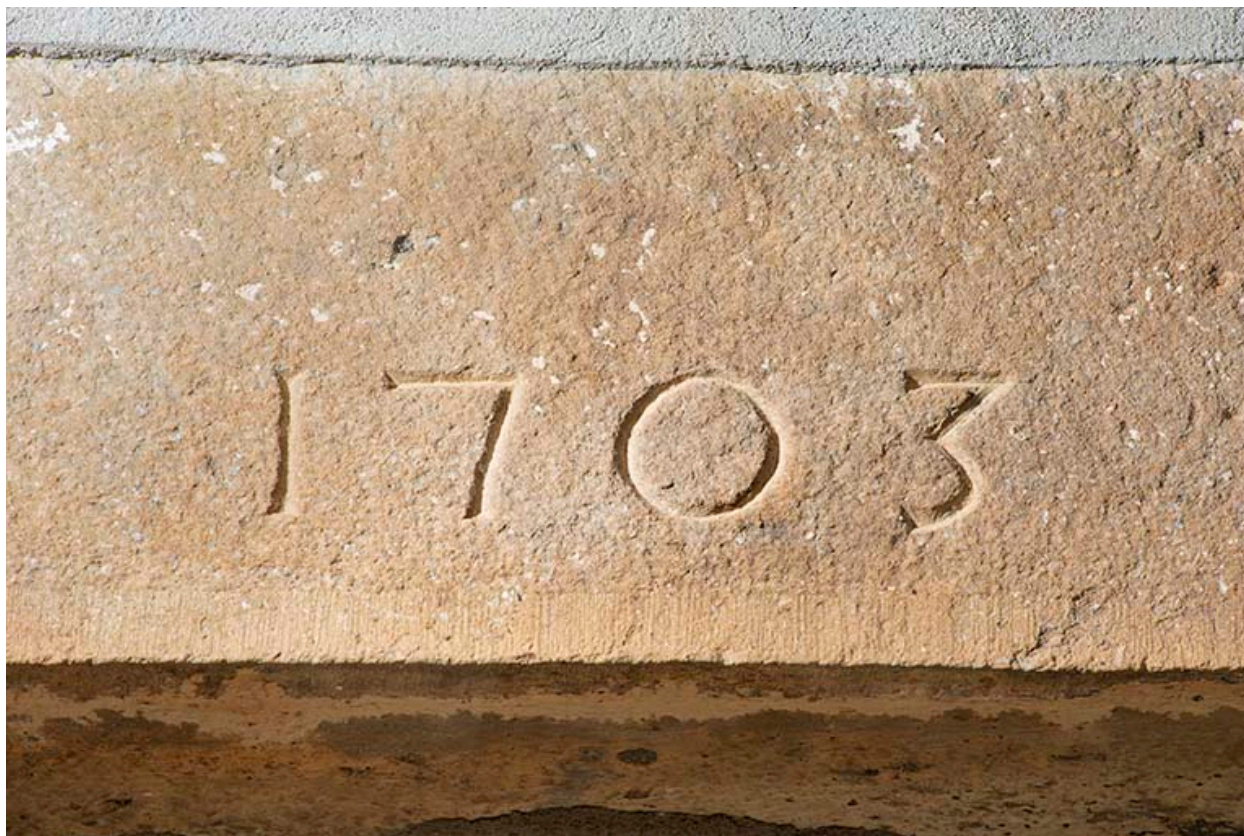
Détail du linteau.
