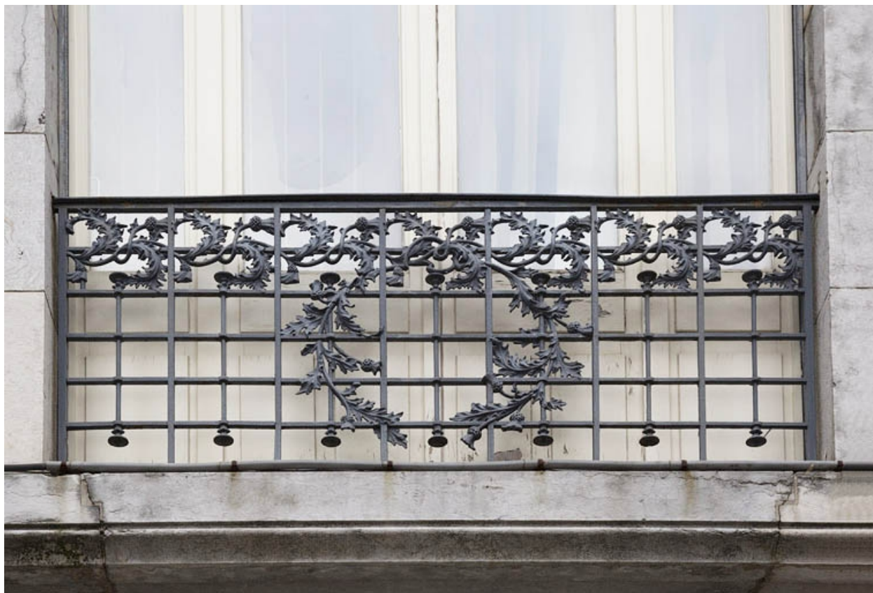
Détail du balcon d'angle du premier étage.
