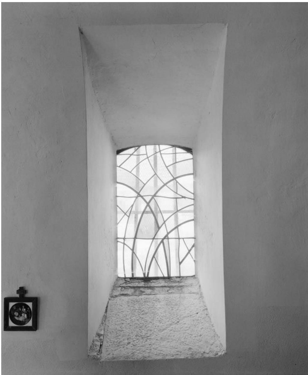
Fenêtre postérieure gauche.
