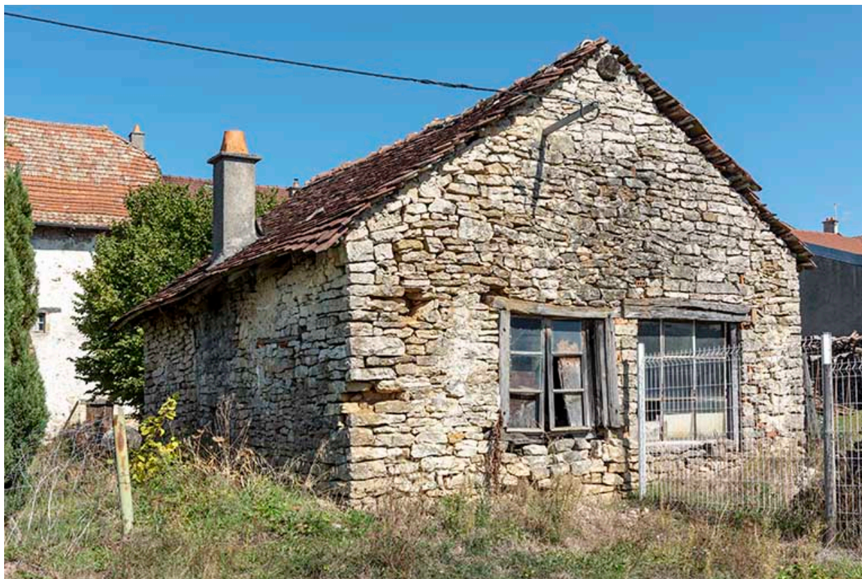
Forge : façade postérieure, de trois quarts gauche.
