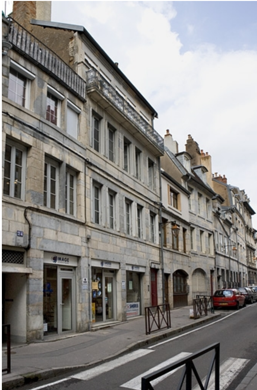
Vue d'ensemble rapprochée de la façade principale dans l'alignement de la rue.
