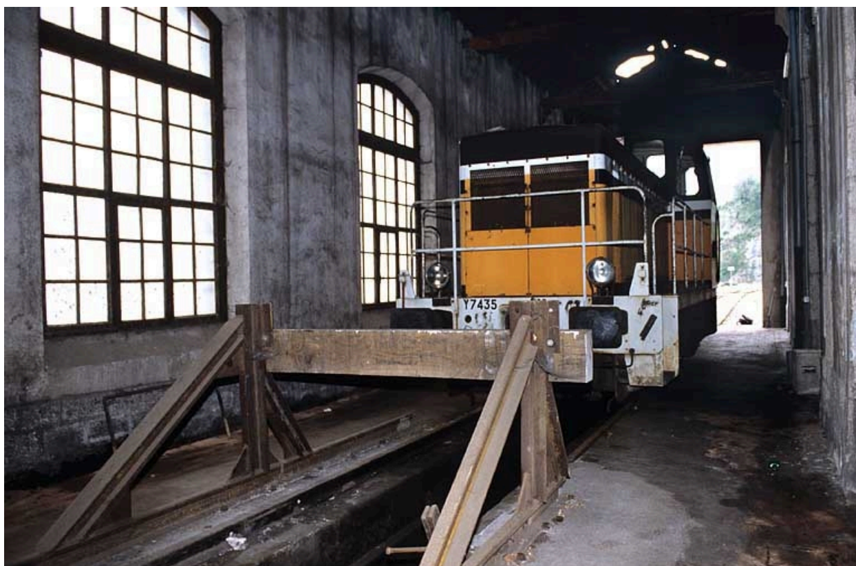
Exemple de butoir dans la remise ferroviaire (halle est).
