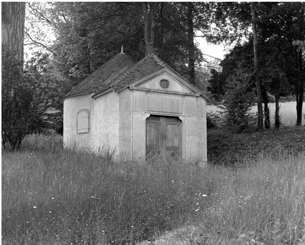
Chapelle dans le parc : vue d'ensemble.
