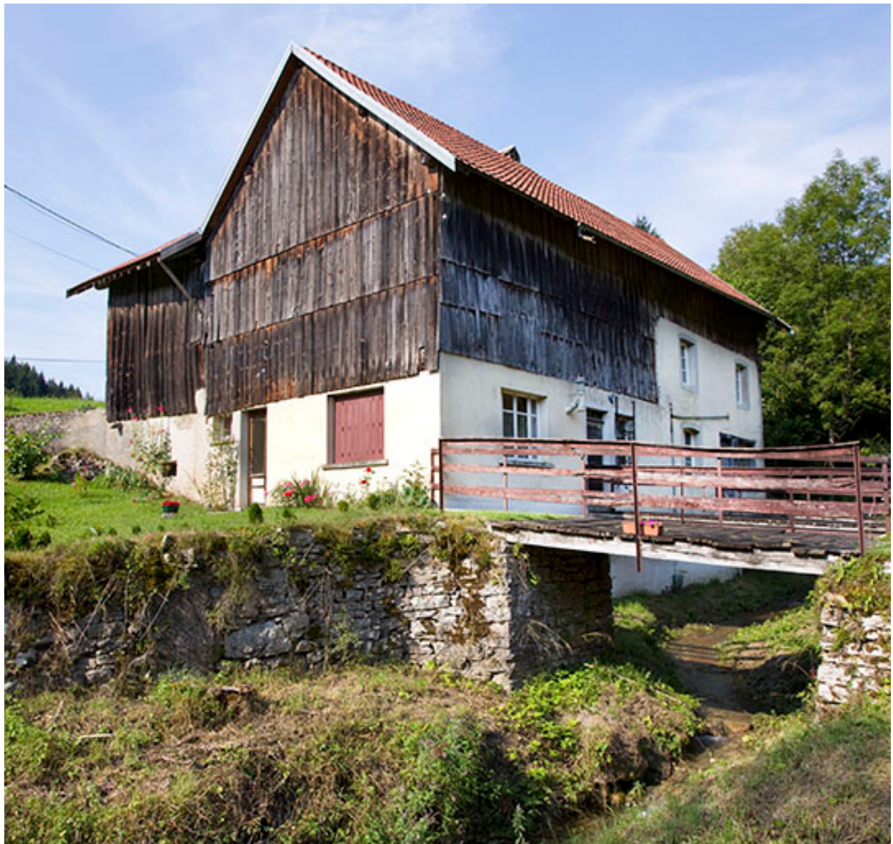
Scierie : façades postérieure et latérale droite.
