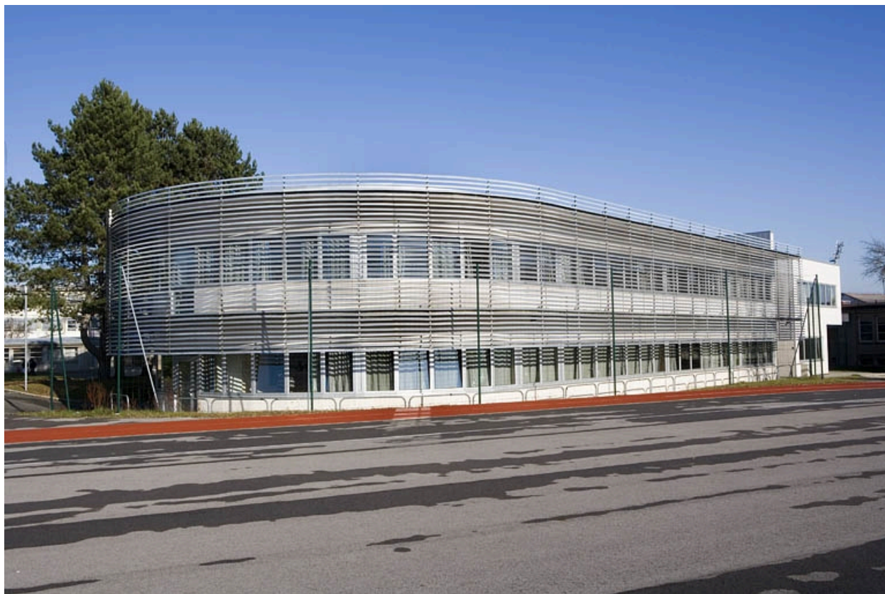
Vue de l'aile droite bâtiment L.
