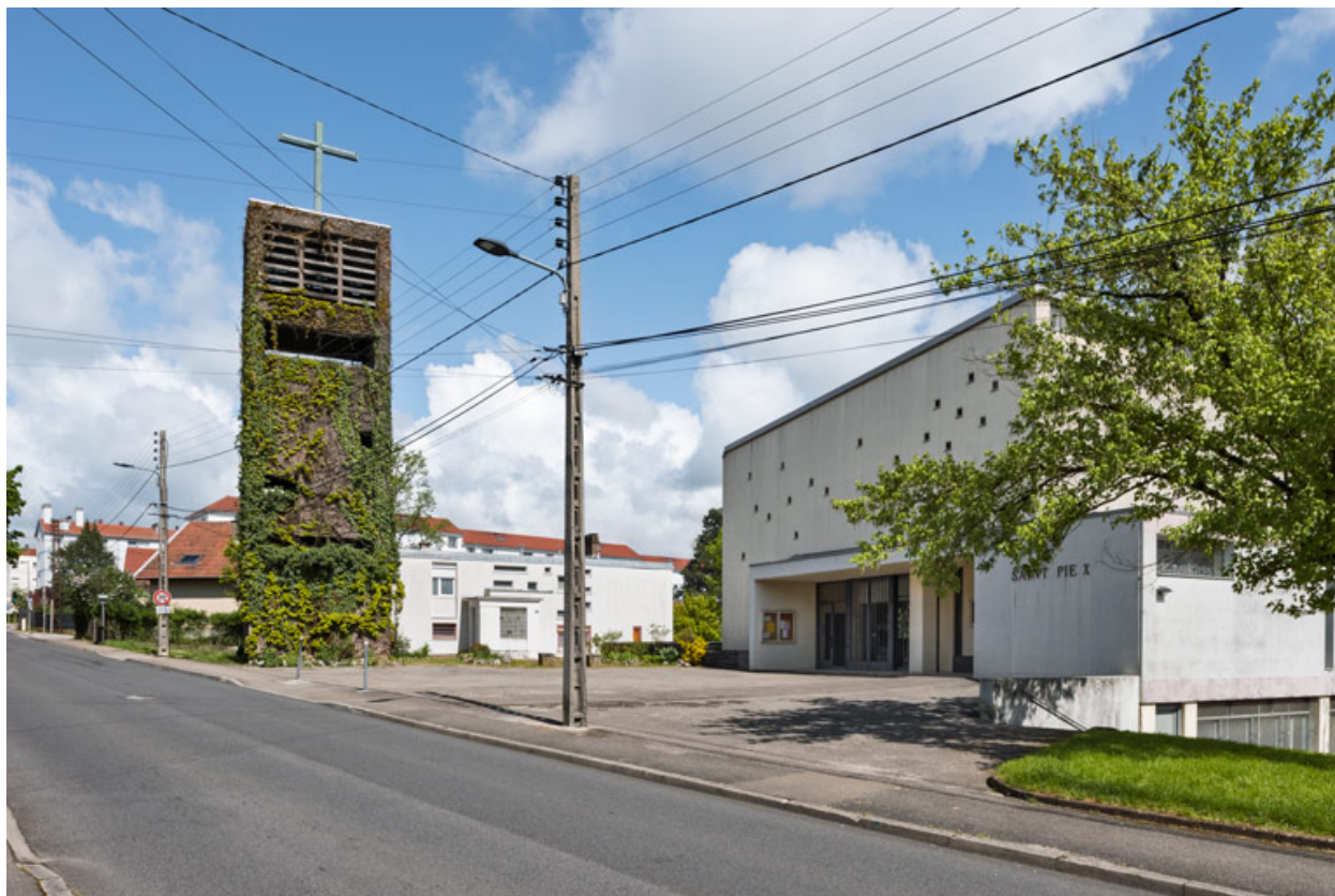
Place-parvis. Vue d'ensemble, de trois quarts.
