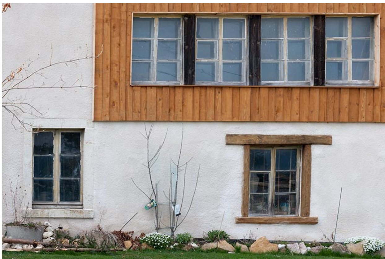
Fenêtres multiples de l'atelier.
