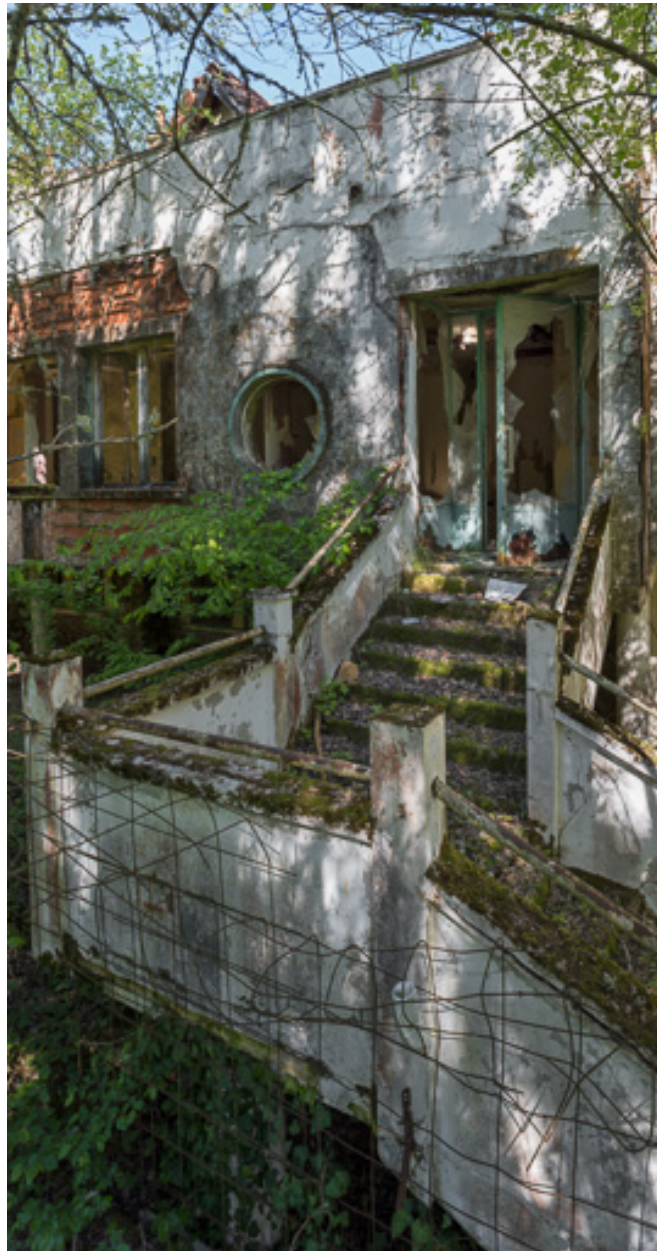
Bâtiment principal, façade antérieure, porte d'entrée précédée de son perron.
