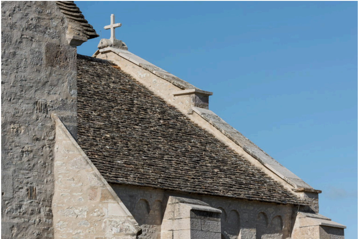
Couverture de la nef.
