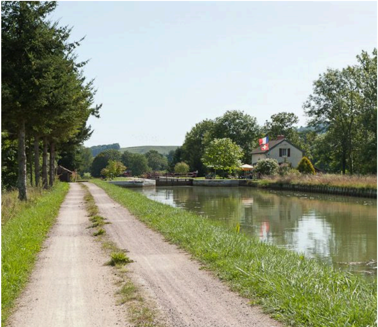
Vue du site d'écluse en amont.
