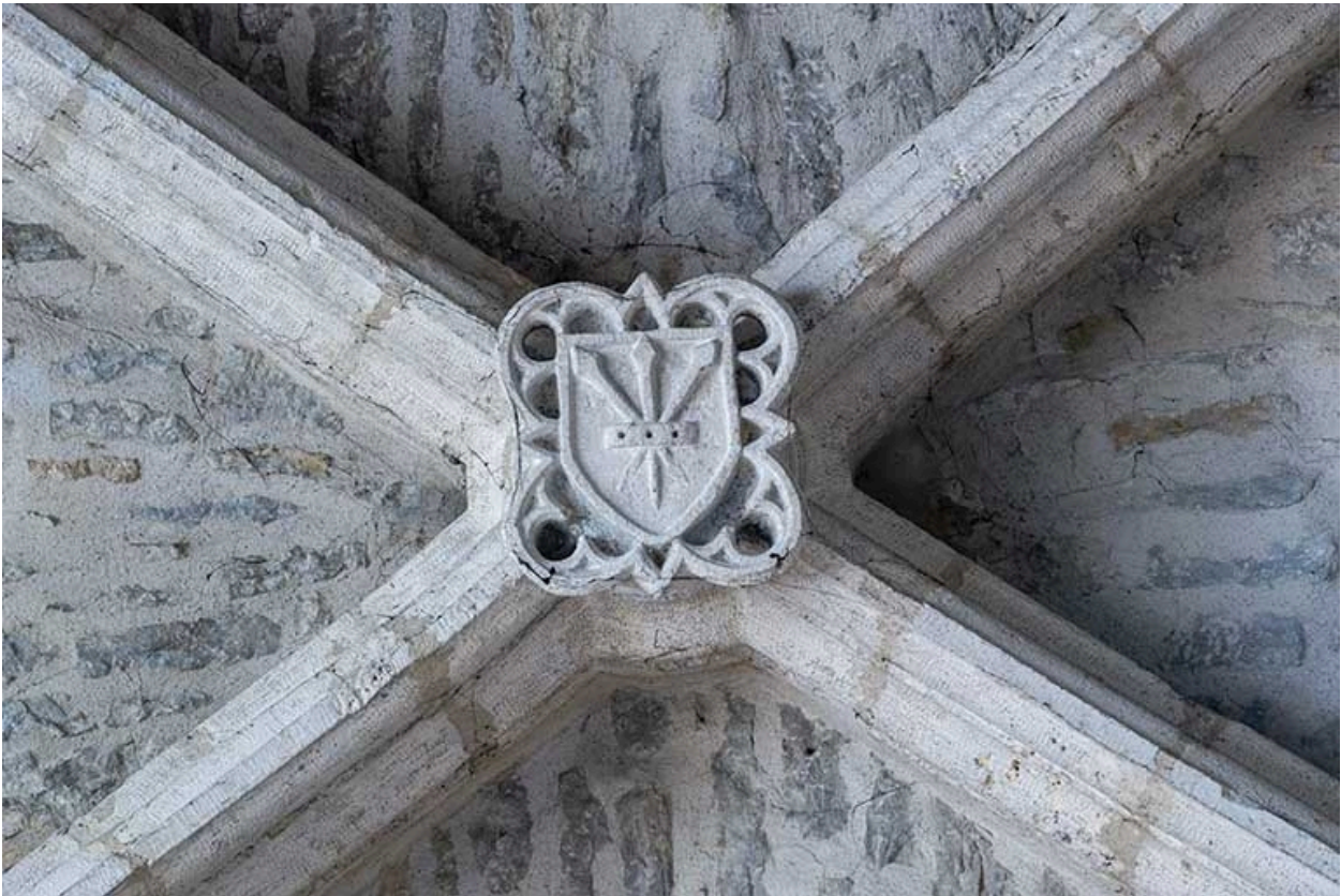
Clef de voûte de la chapelle, écu portant trois clous appointés.
