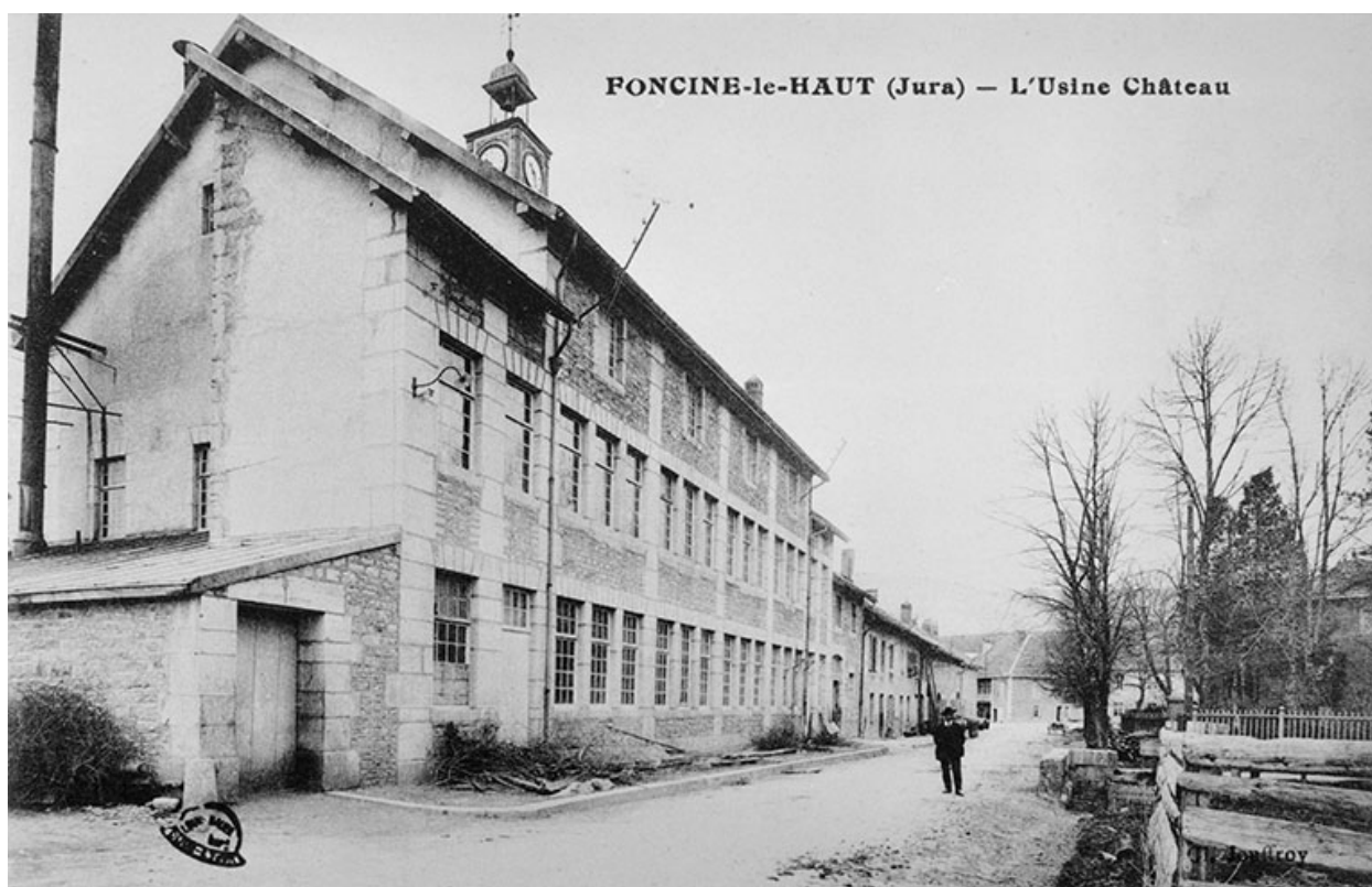
Foncine-le-Haut (Jura) - L'Usine Château, 1er quart 20e siècle [entre 1903 et 1919].
