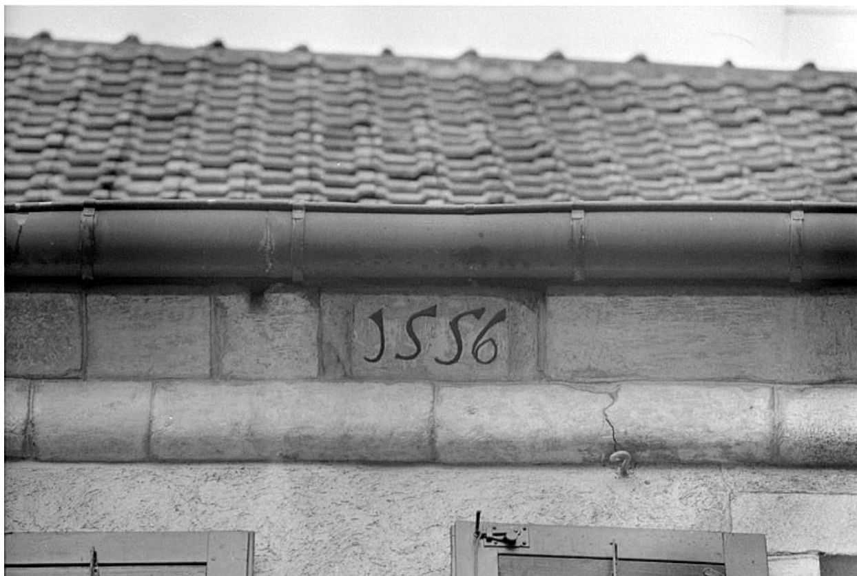
Façade sur rue, détail de la corniche.
