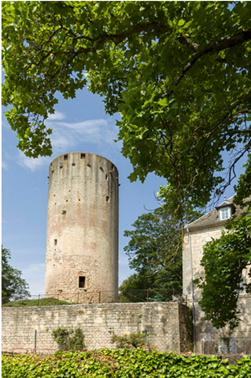
L'ancienne entrée du donjon vue depuis l'est.
