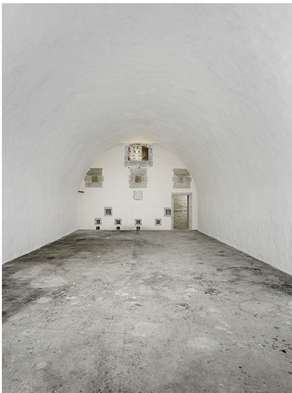
La chambre de stockage du magasin à poudre : vue en direction des baies d'éclairage.
