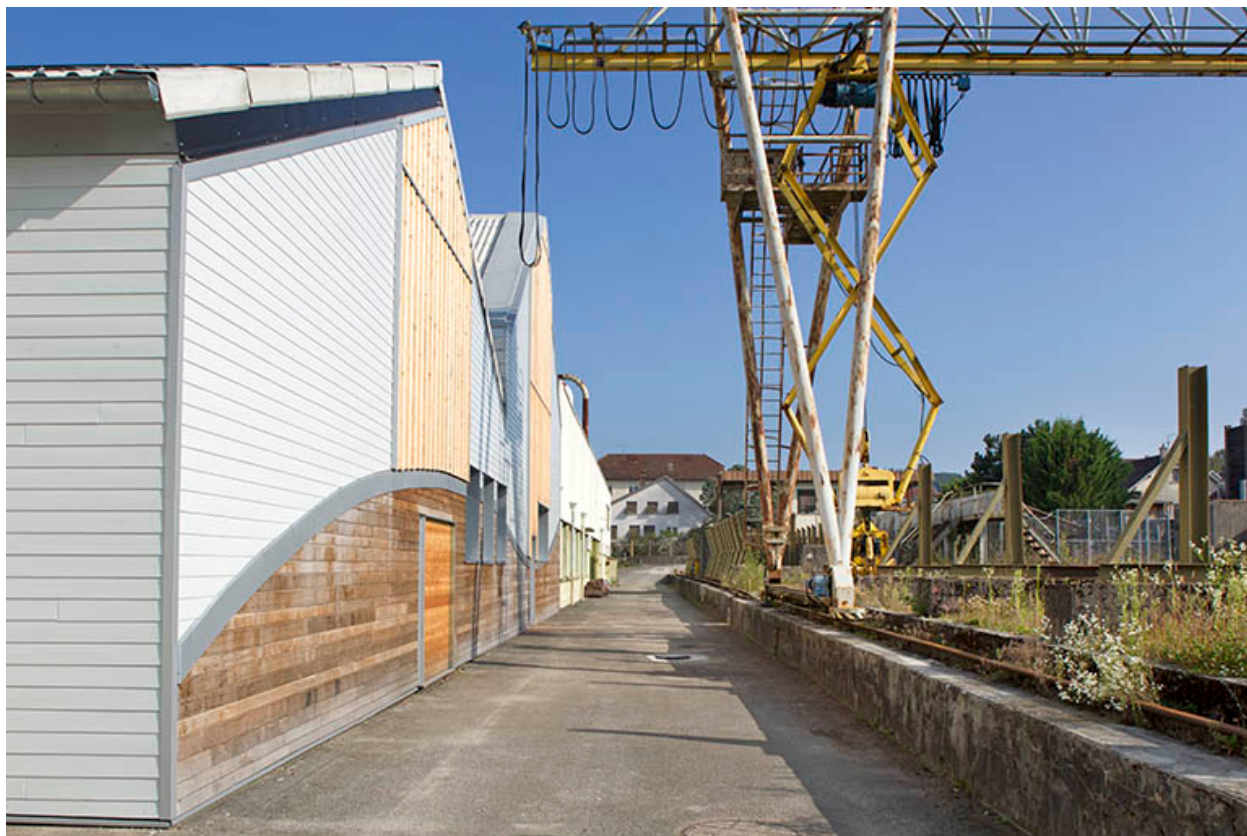
Ateliers : façade antérieure.
