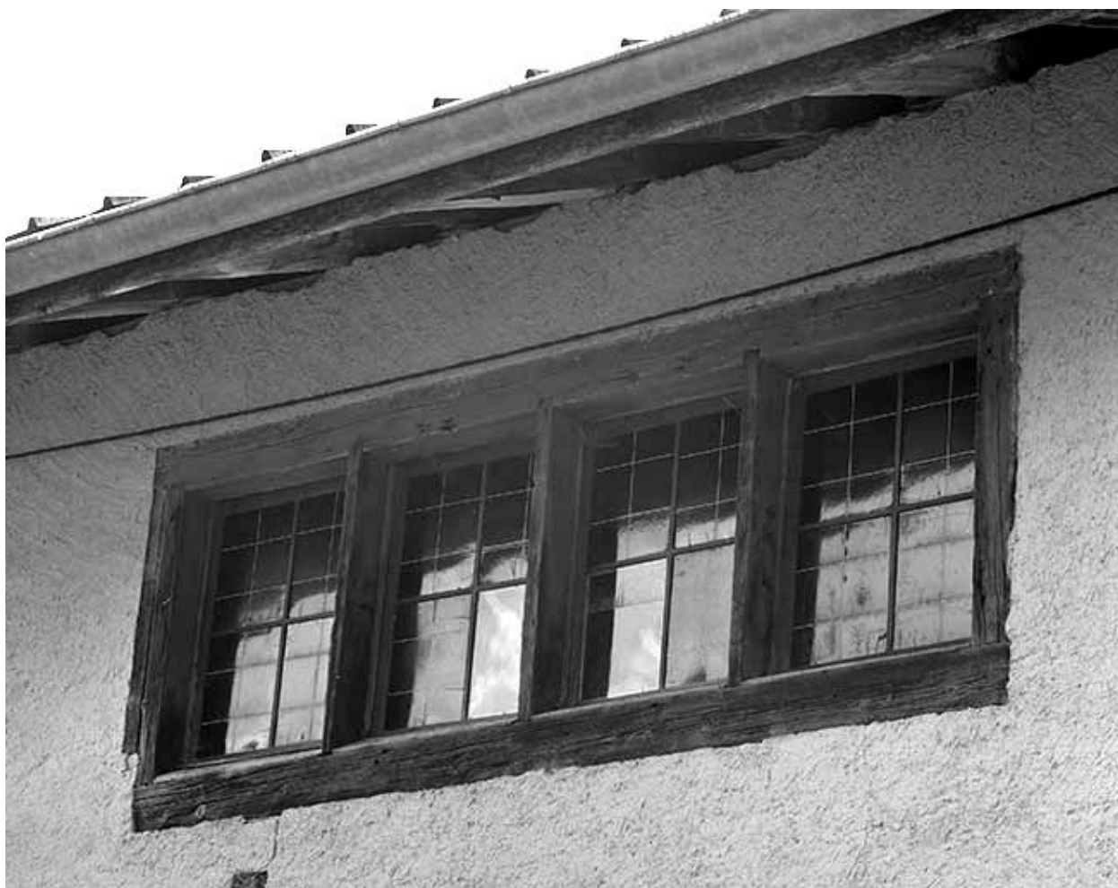
Fenêtres éclairant l'atelier ou " fenêtres de forge ".
