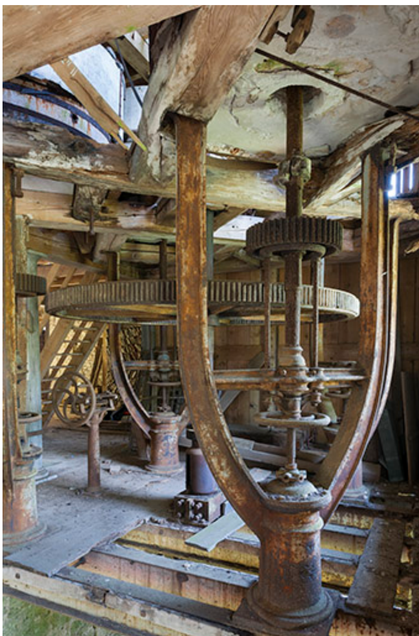
Rez-de-chaussée. Les colonnes "en lyre" du beffroi.
