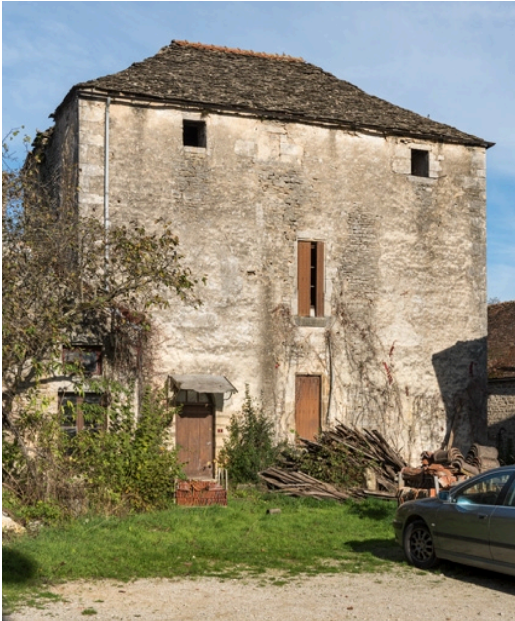
Vue de la façade sud.
