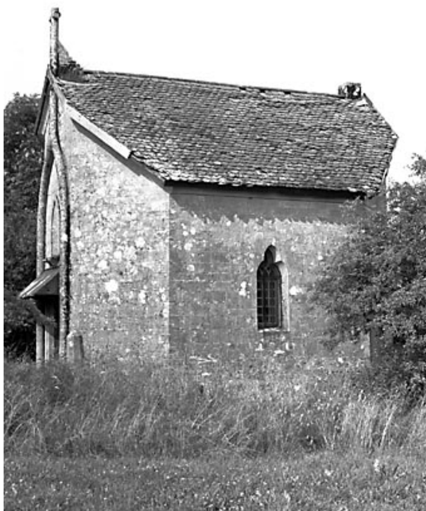
Façade latérale droite.
