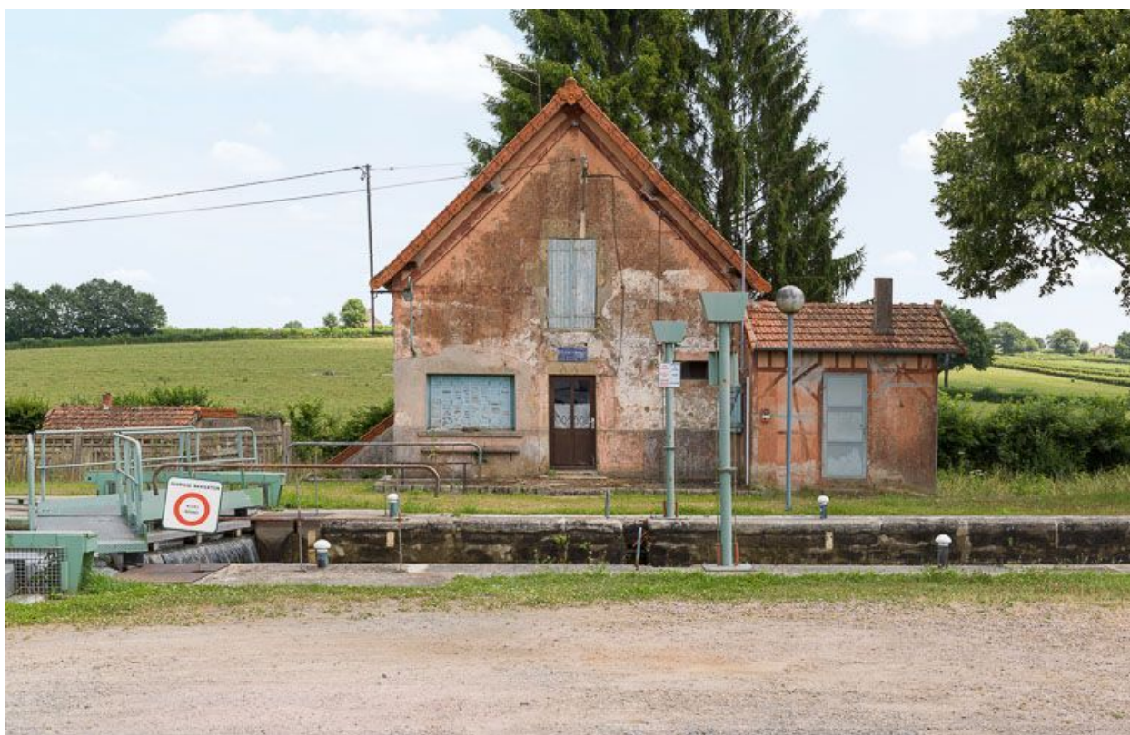
La maison éclusière de face.
