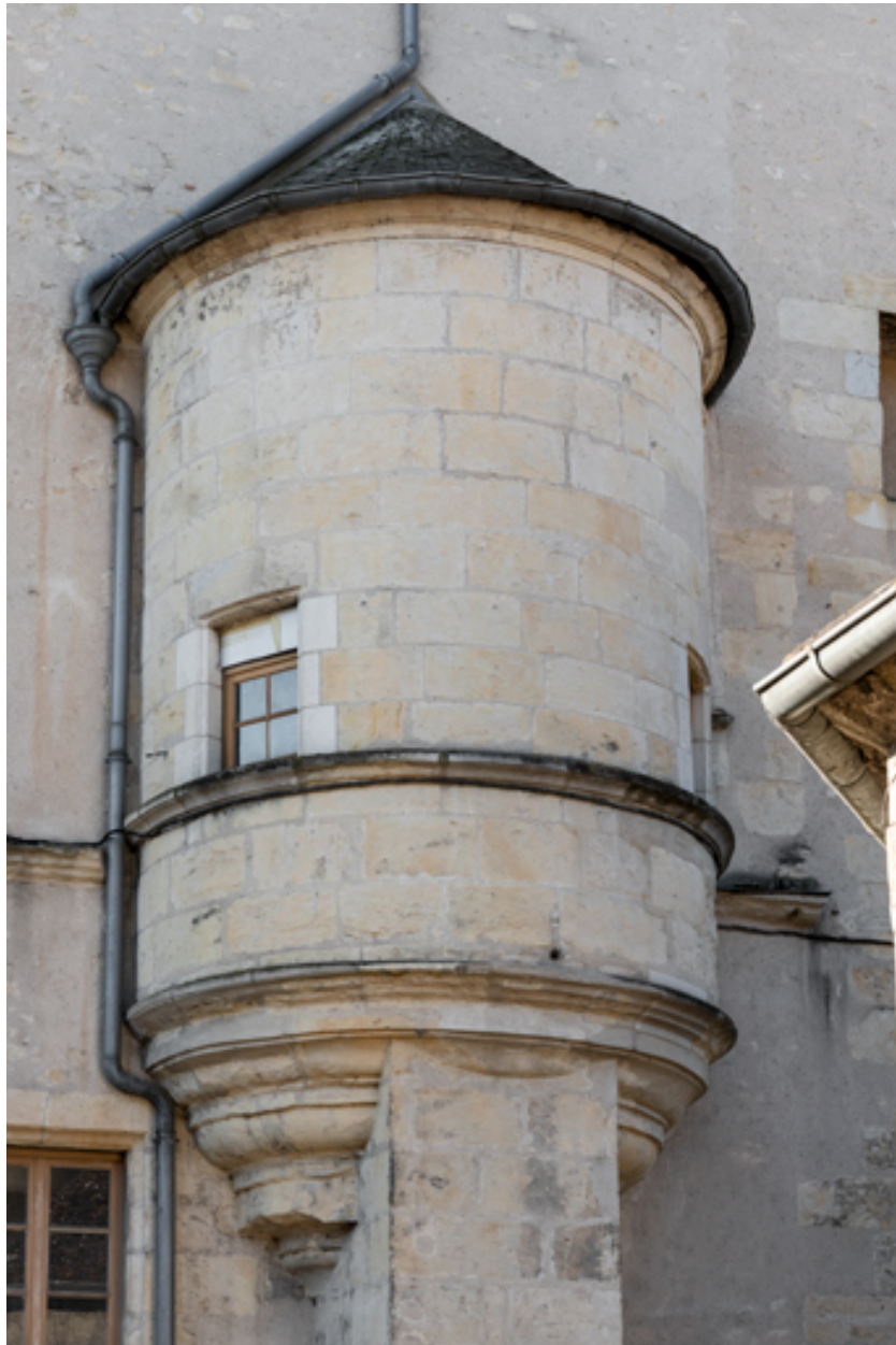
Façade postérieure : échauguette.
