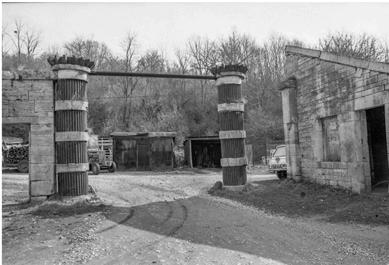
Portail de l'usine, depuis la cour, en 1979.
