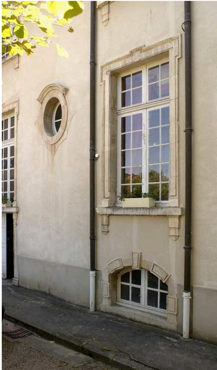
Ancien hôtel du gouverneur : élévation antérieure, porte d'entrée principale et fenêtres.
