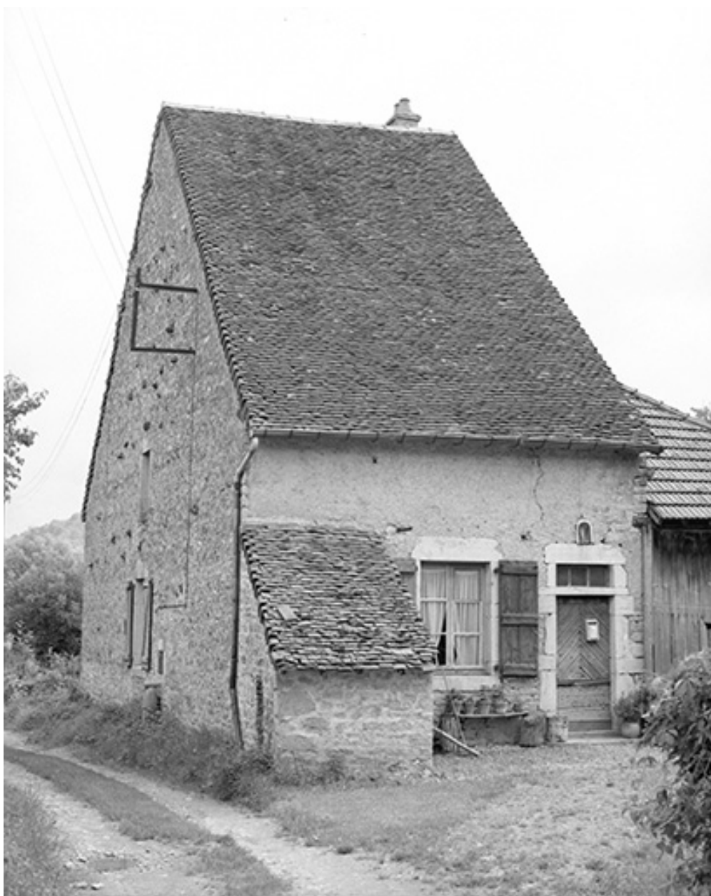
Maison : façades antérieure et latérale gauche.
