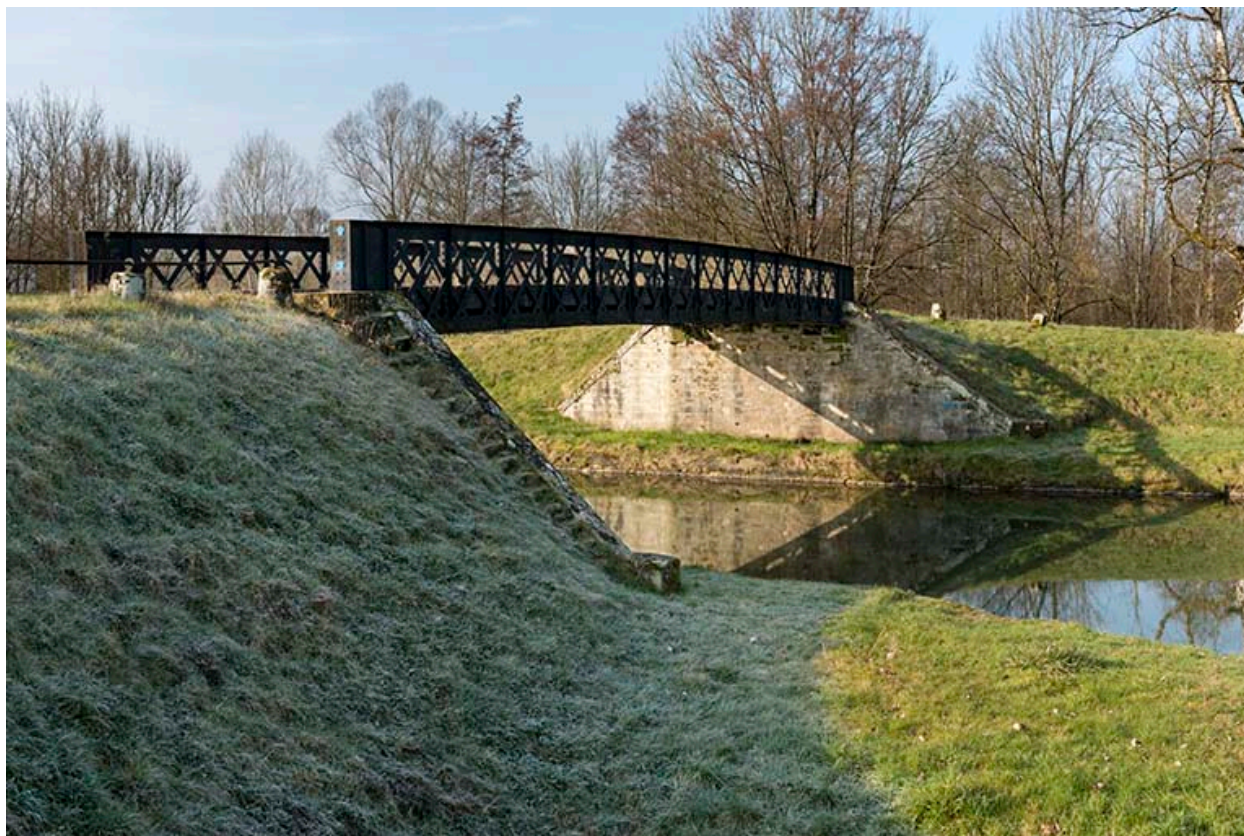
Pont du Devez.
