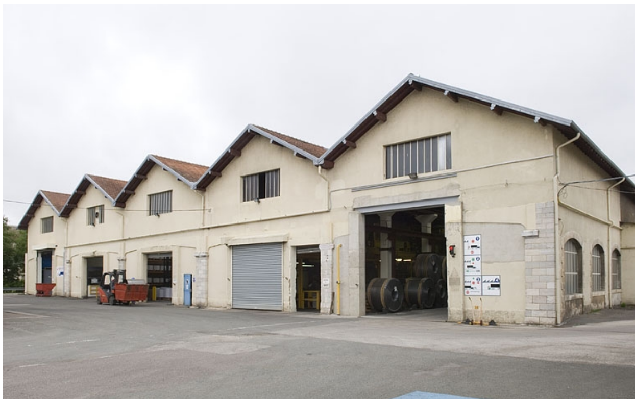
Atelier de fabrication (ancien atelier des locomotives).
