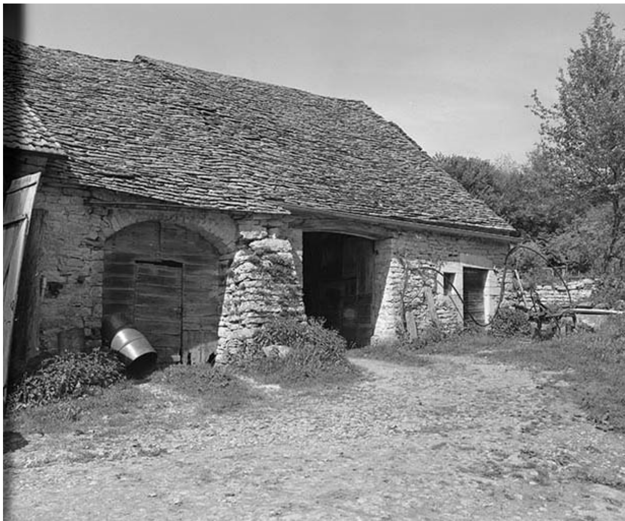
Façade antérieure, partie droite.
