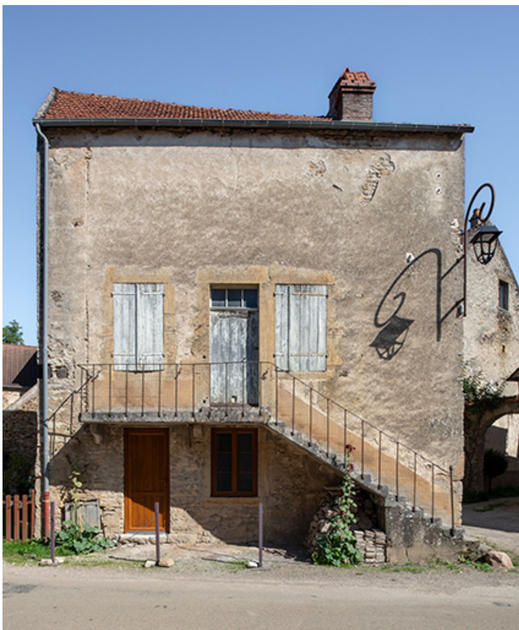
La maison depuis la rue.
