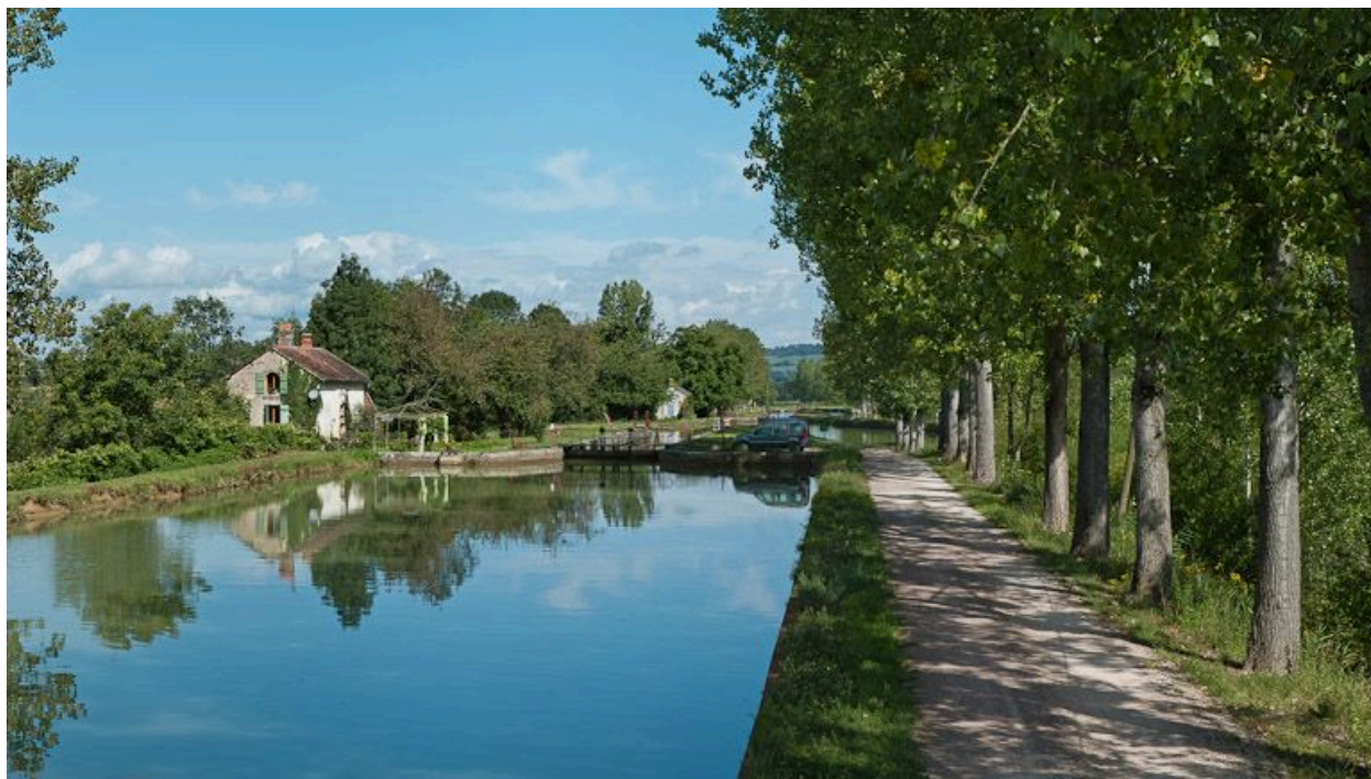
Vue du site d'écluse depuis l'amont.
