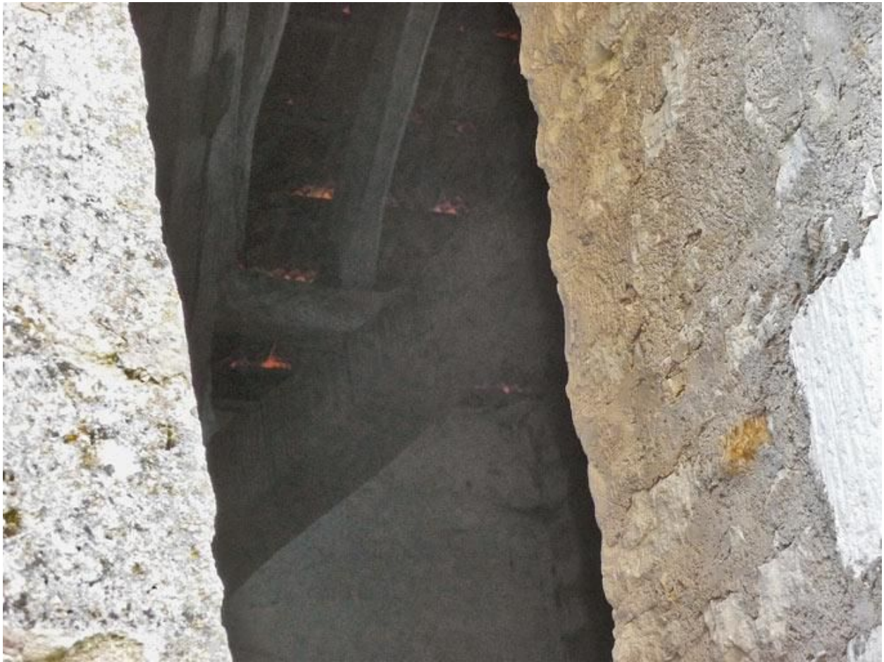
Chapelle, corps antérieur : détail de la charpente.
