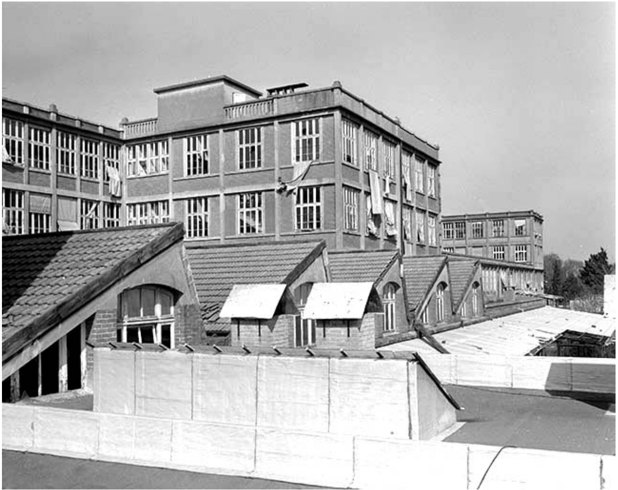
Façade postérieure et sheds.
