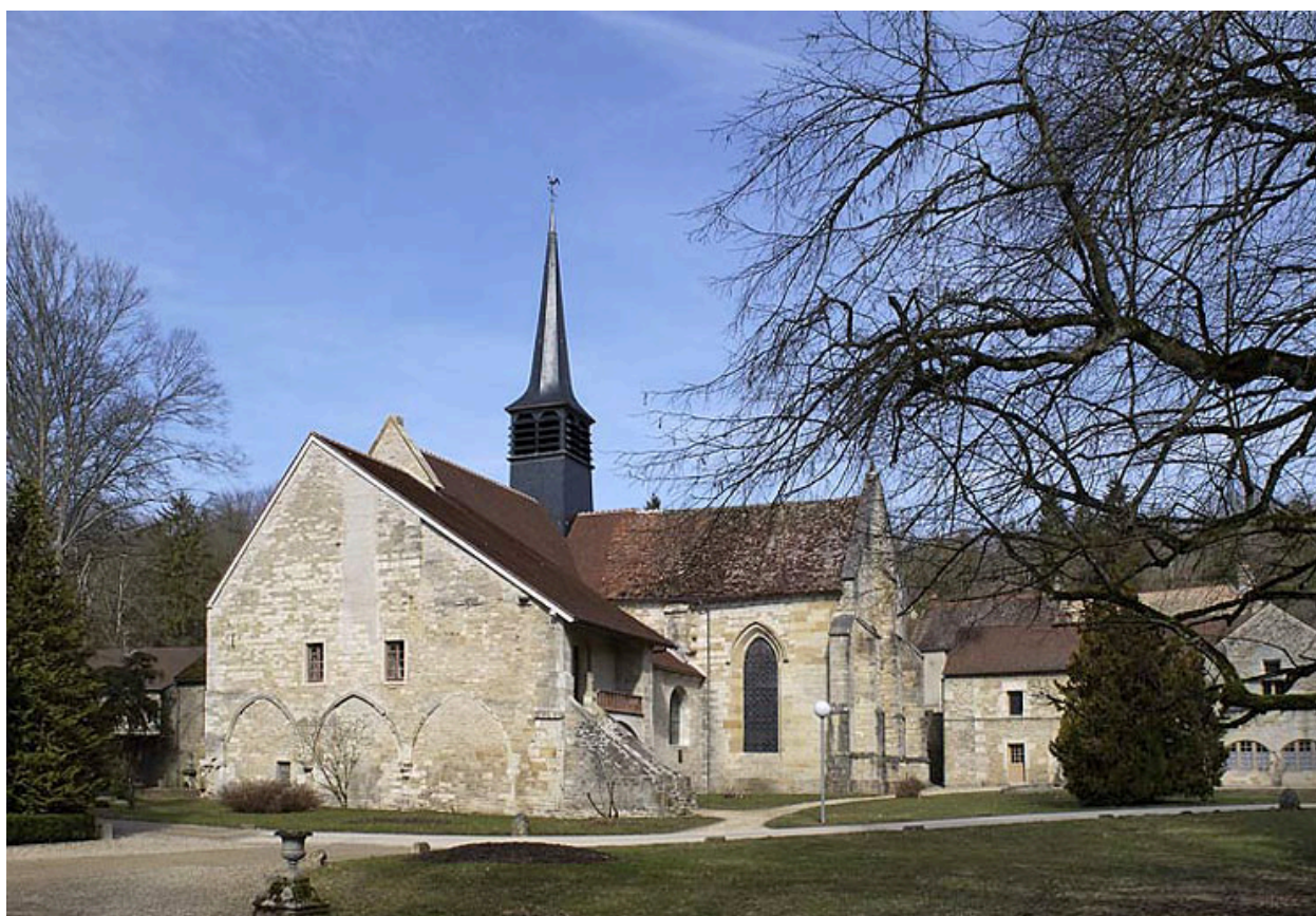
Extrémité nord de l'aile orientale, vue du sud-est.
